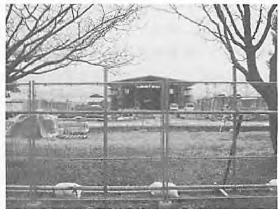
平城遷都1300年祭会場建設中 (平城宮跡)
