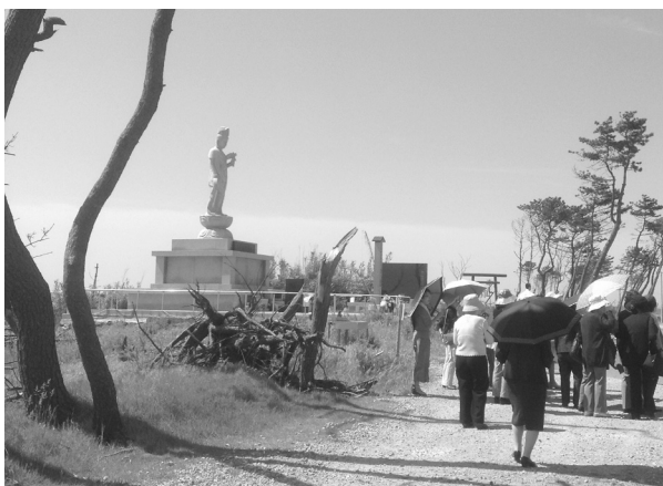
9mの津波と同じ高さにて建てられた観音像(荒浜地区)
